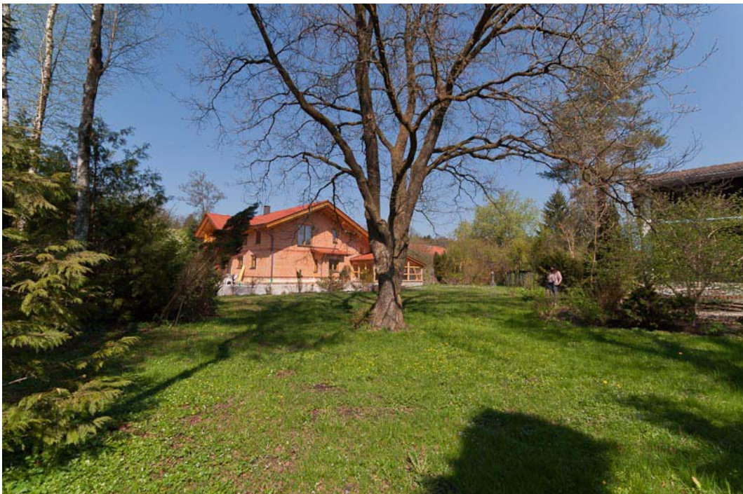
Grundstück 2, Blick nach Nord-Westen
